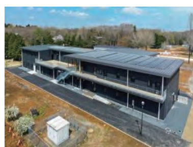
写真3：新管理棟の全景
