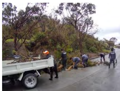
台風後の道路復旧作業(実習Ⅱ)
