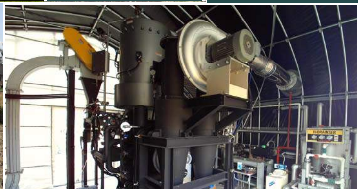
産官学連携事業 「バイオマス蒸気ボイラーとロータリー発電エンジン独立熱電システムによる施設園芸」
