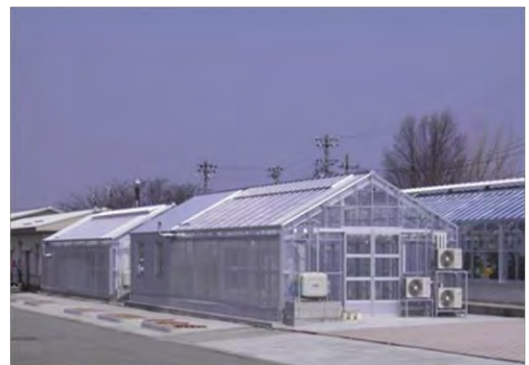
更新した温室
