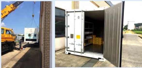
実習棟横に設置された高性能冷蔵コンテナ
