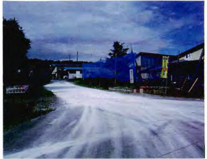
消石灰帯の設置
