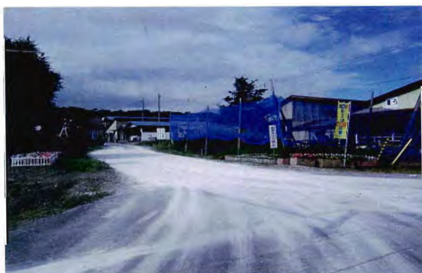
消石灰帯の設置
